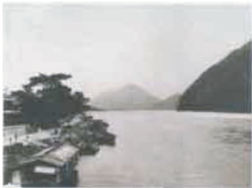
長良橋より上流を望む（岐阜市長良付近）
